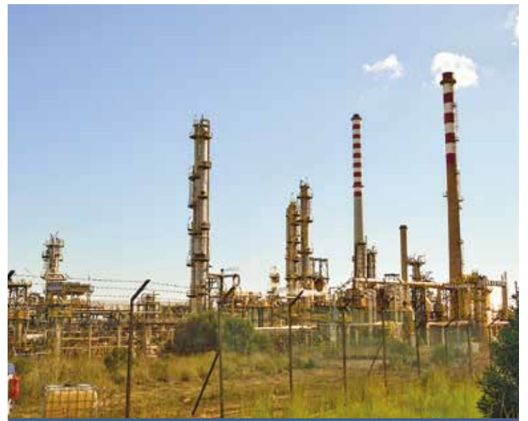
UN IMPIANTO INDUSTRIALE
